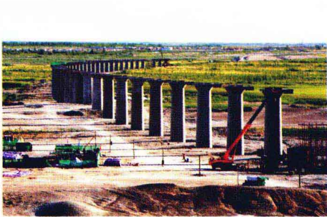
建设中的奎北铁路
