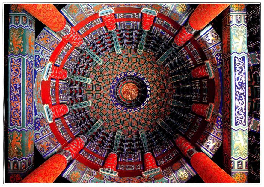
新年殿是中國木結構建築中的精品。中間藻井由四根龍井柱支撐。柱子上接方形的地樑和圓形的天梁,天梁上另增八根雷公柱,加龍井柱 共十二柱一起承受藻井。藻井由兩層斗拱及一層天花組成,中間爲金色龍鳳浮雕,結構精巧,富麗華貴。
