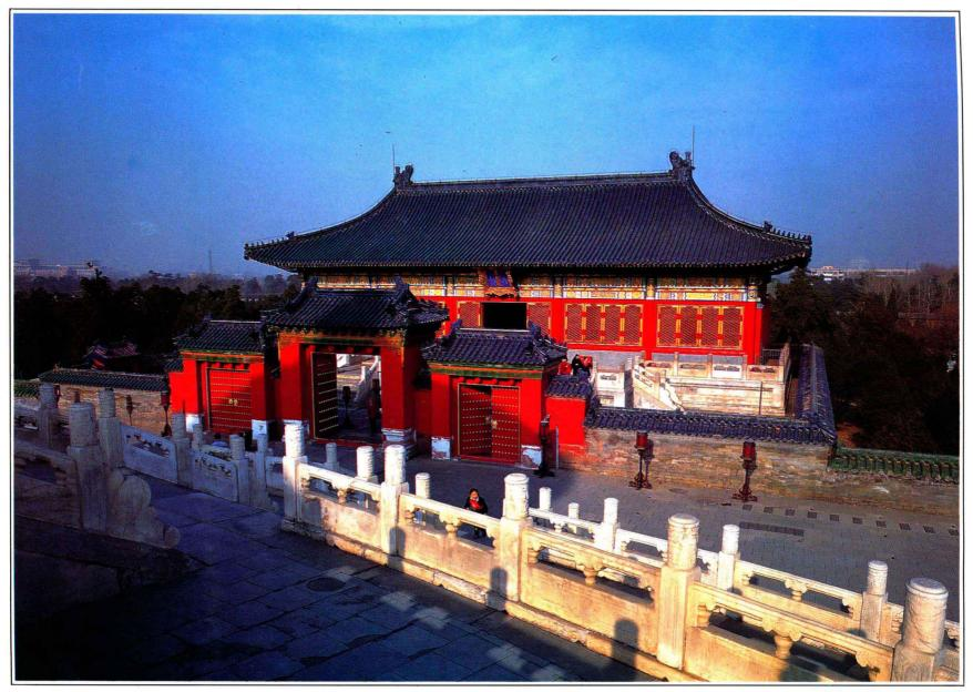
皇乾殿建成於明朝永樂十八年(1421年)、五開間,廡殿式建築,藍色琉璃頂,基座帶欄板、望柱,南面月台東、西、南三面出台階,各八級,望柱浮雕龍、鳳紋相間,大殿內外飾龍鳳和諧彩畫。殿前琉璃三座門是中國古建中的珍品。
