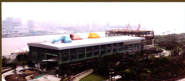
2009年9月24日改建中的上海第三钢铁厂车间
