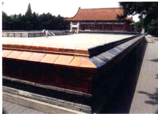
▲社稷坛以四色矮墙及东南西北四座石牌坊围合而成，最北面为戟门，中间坛面铺黄、青、红、白、黑五色土
