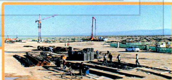
在建中泰化学
