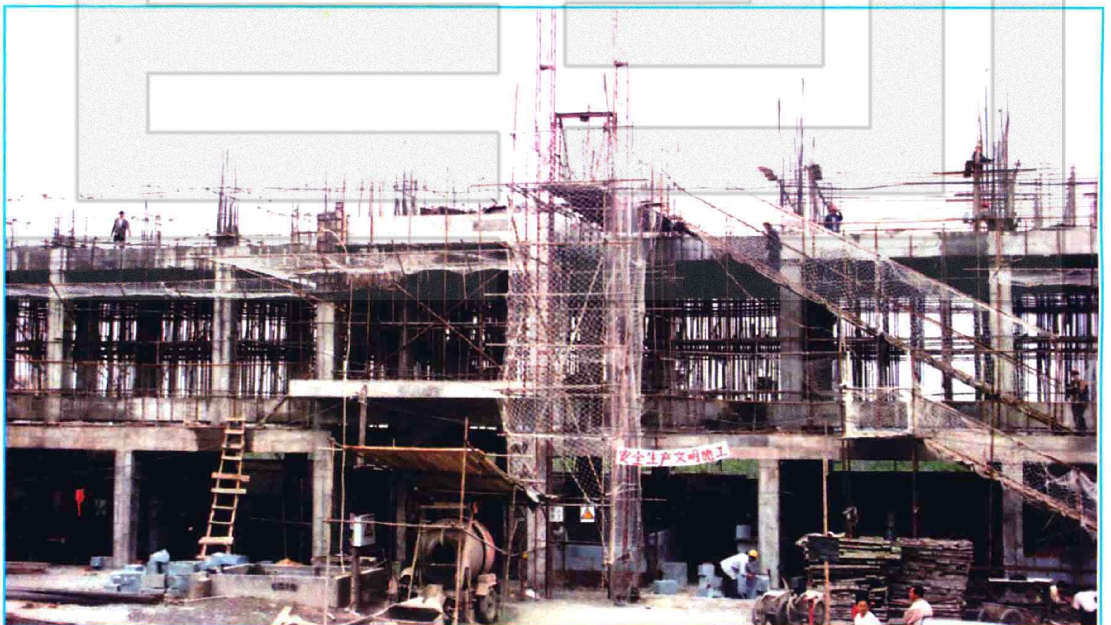
建设中的商贸楼
