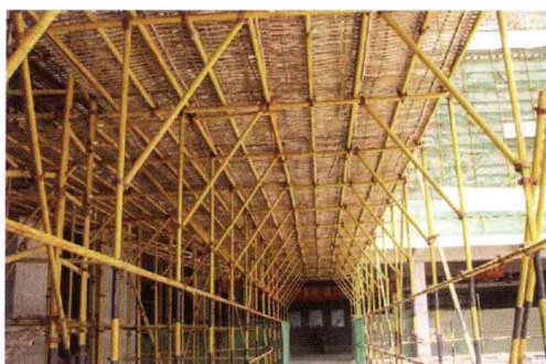
施工安全通道
