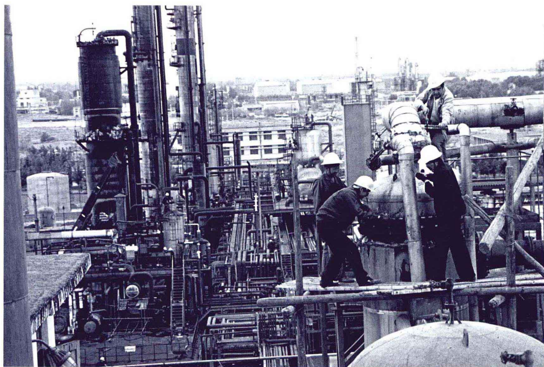
建设中的炼油厂一角
