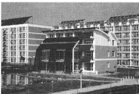
图1-11 太阳能热水系统在建筑中的应用1
