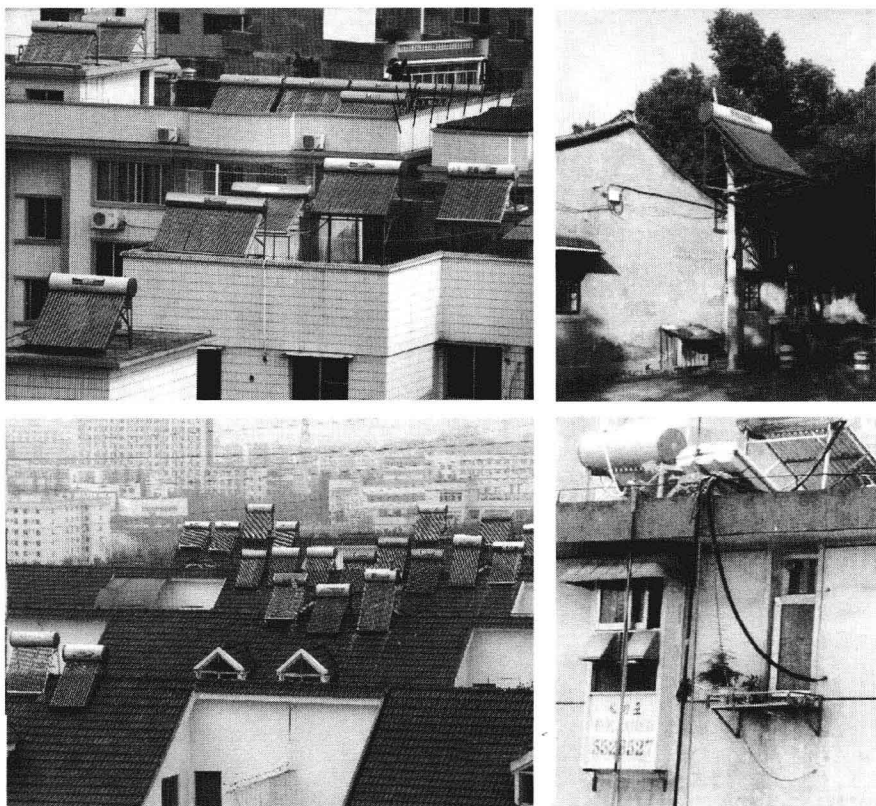
图1-18 太阳能热水器破坏建筑外立面
