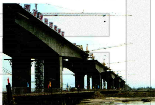
建设中的伊犁河大桥(新建)
