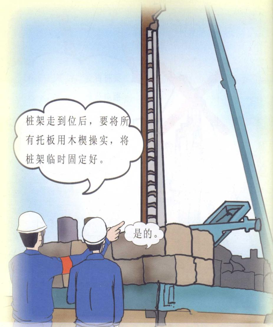
落锤式打桩机：（2）桩架走到位后，应将所有托板用木楔操实，并将桩架临时固定好。
