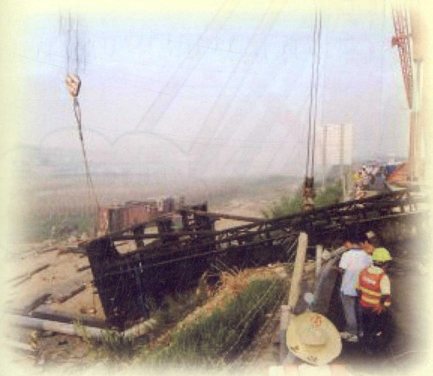
打桩架：（2）风速超过15m/s时，应停止作业，导杆上应设置缆风绳。当风速大到30m/s时，应将导杆放倒。当导杆长度在27m以上时，预测风速达25m/s时。导杆也应提前放下。
