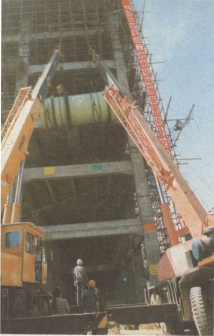
建设中的年产24万吨的 磷铵工程 黄山华
