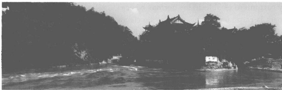
Vista del "Baopingkou" (Boca de jarra preciosa) del Proyecto Hidráulico de Dujiagnyan, es un compartimiento principal para la irrigación en forma de cuello de botella.
