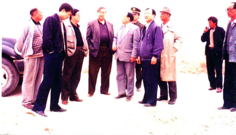
1998年3月新疆维吾尔自治区土地局长夏力甫汉（左5），带领工作人员在阿图什火车站建设现场，落实车站建设用地问题。
