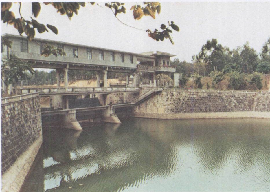
横岗水库溢洪道弧形闸门
