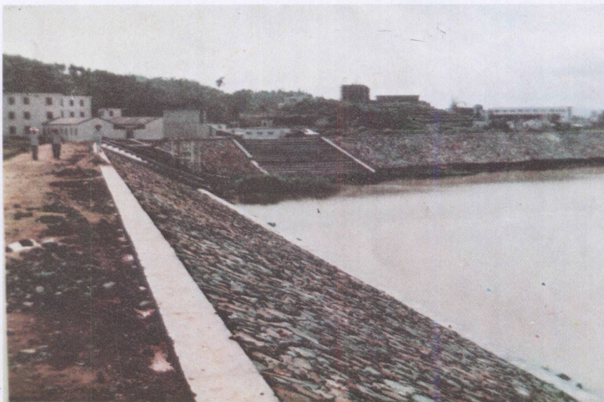
风岗镇石马河堤
