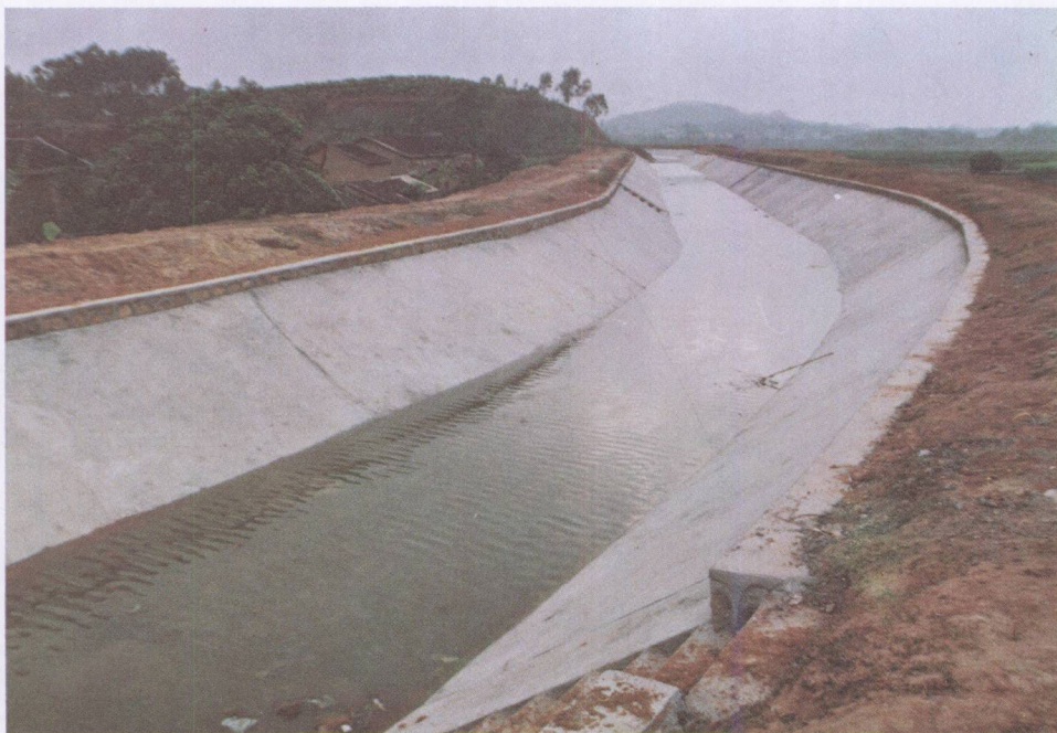
同沙水库寮步高渠首段
