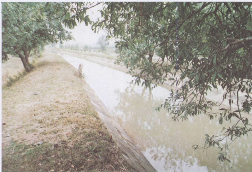
旗岭灌区西总干渠
