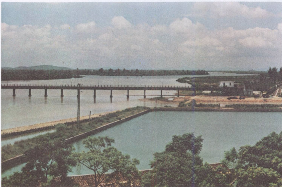
横跨东引运河的镇口渡槽
