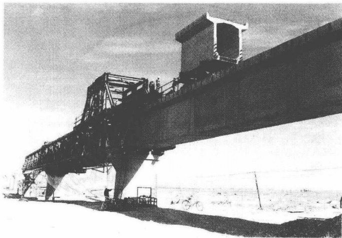
图 1-4 移动支架法架梁
