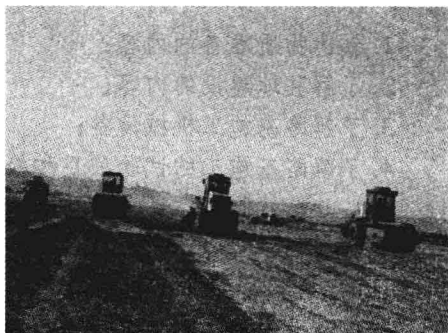
图 1-5 路基施工机械
