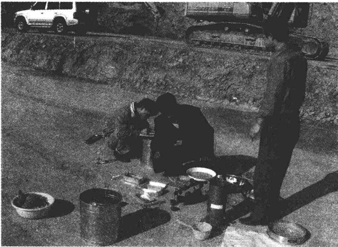
图 1-6 路基现场检测
