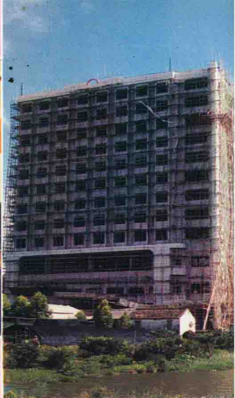
即将竣工的 12 层商贸大厦。▶
