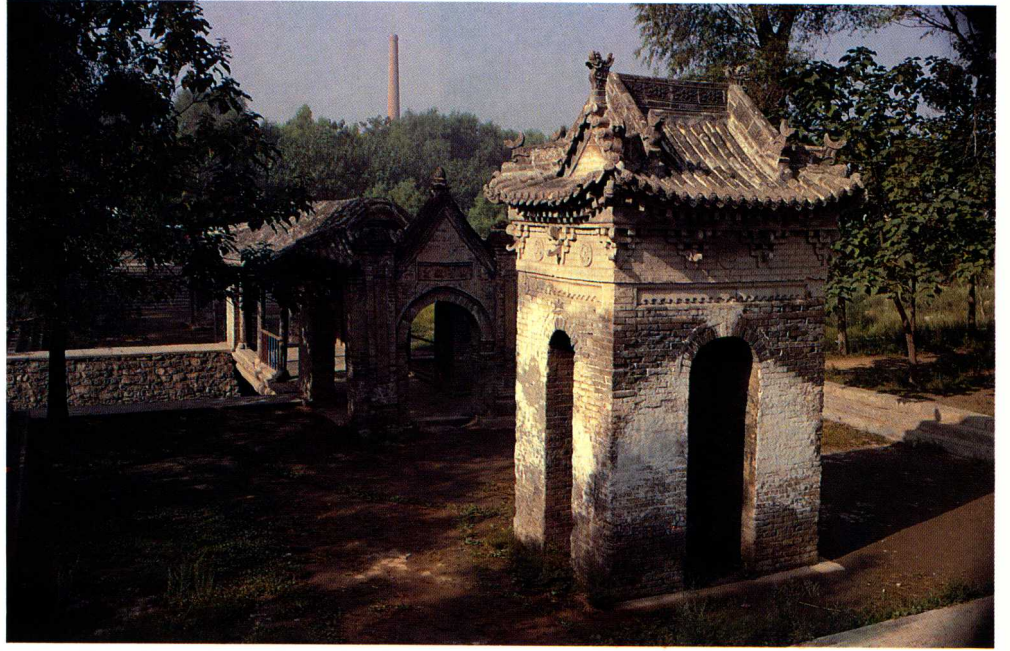
山西洪洞廣勝寺分水亭
