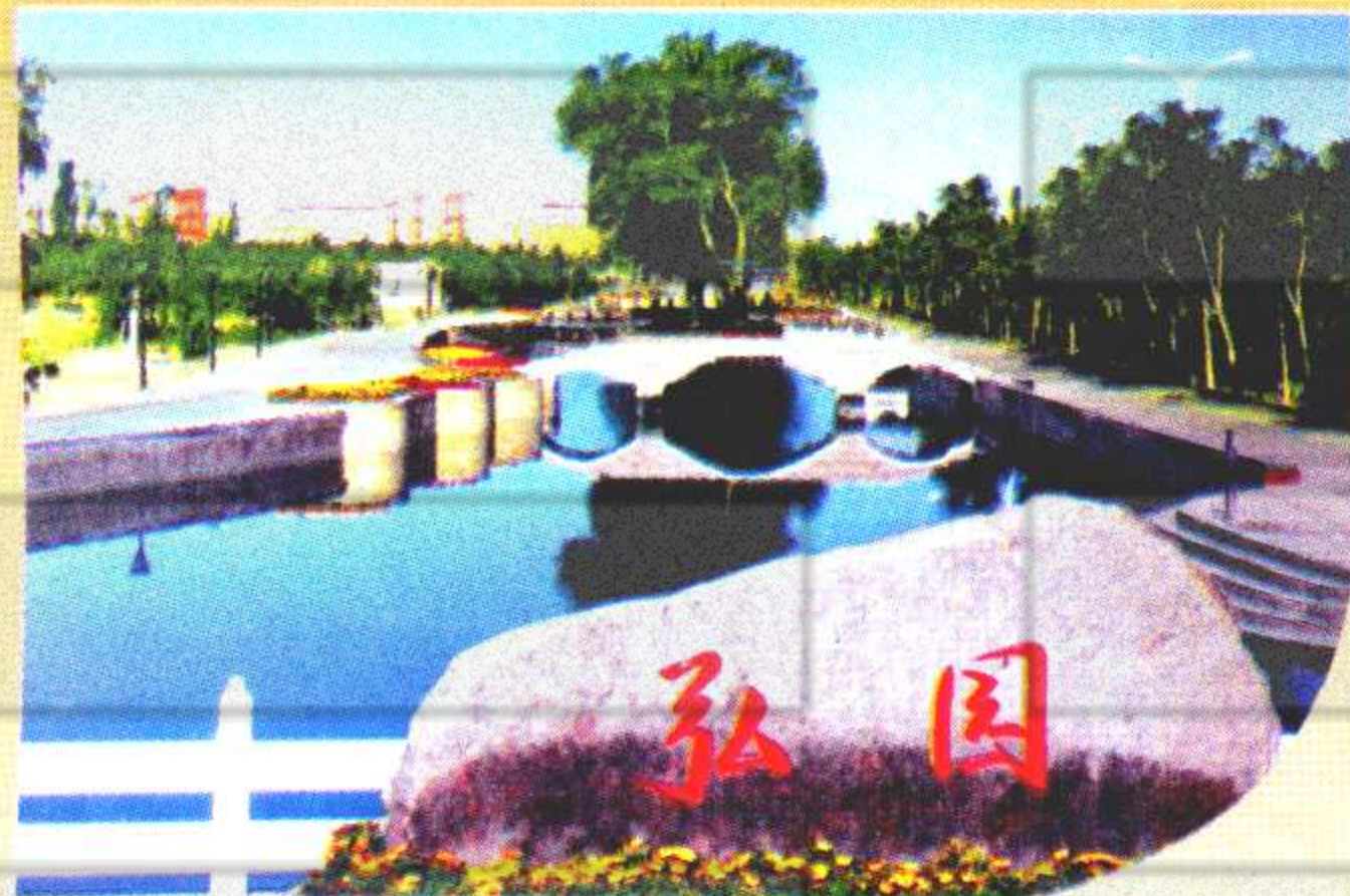
尉犁县兴平干渠改造一段
