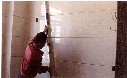
图 1-31 检测大理石的平整度
