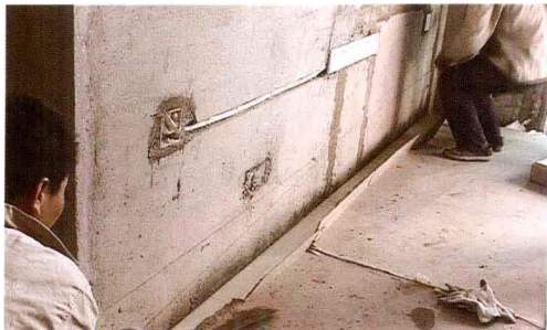
图 1-7 弹好地脚线施工高度线
