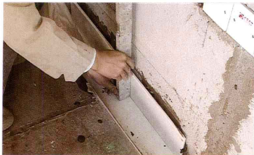
图 1-9 量好地脚线的垂直度
