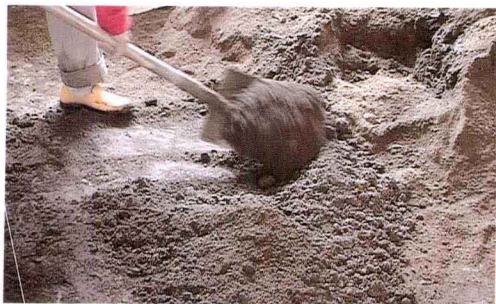
图 1-34 搅拌水泥砂浆
