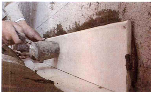
图 1-10 用橡皮锤敲实定位
