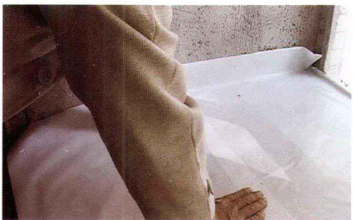
图 1-6 大理石面层贴保护膜保护
