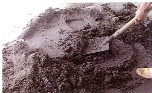
图 1-14 搅拌水泥砂浆
