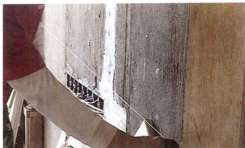
图 1-23 打好横竖水平线
