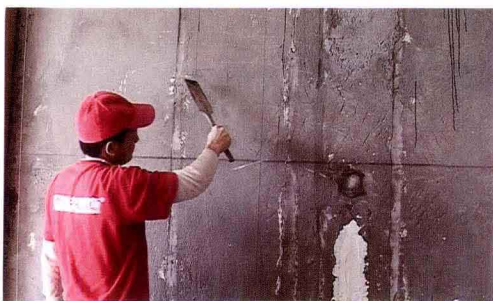
图 1-19 清理墙面基层
