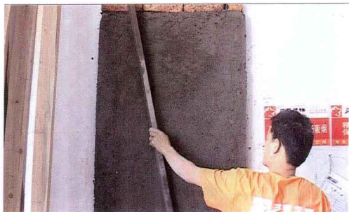
图 1-18 检测批荡的平整度
