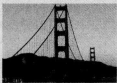
金门大桥，是世界著名大桥之一，被誉为近代桥梁工程的一项奇迹，也被认为是旧金山的象征。金门大桥于 1933 年动工，1937 年 5 月竣工，用了 4 年时间和 10 万多 t 钢材，耗资达 3550 万美元。整个大桥造型宏伟壮观、朴素无华。桥身呈朱红色，横卧于碧海白浪之上，华灯初放，如巨龙凌空，使旧金山市的夜色更加壮丽。
