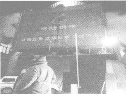
图 1-4 遵化“12·24”重大 煤气泄漏事故
