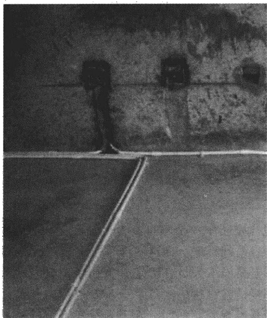
改电过程中墙上画好的线及已开的线槽
