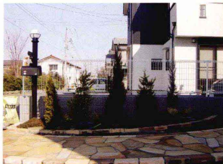
砖瓦隔断的花坛。铺设石材所使用的砂浆。
