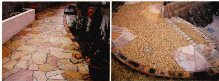
贴石材的引道（左图）和砾石的引道（右图）。 因材料的选择方法不同，风格及完成时的效果也大不同。
