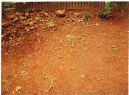
4 铲除5cm左右的深度，再将裸露出的石子及砾石清除。
