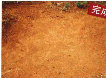
6 地面整修完成。
