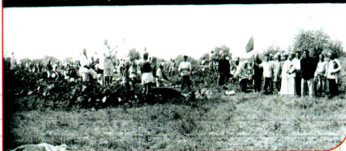
1958年9月18日，阿瓦提县一、三区大渠改道开工
