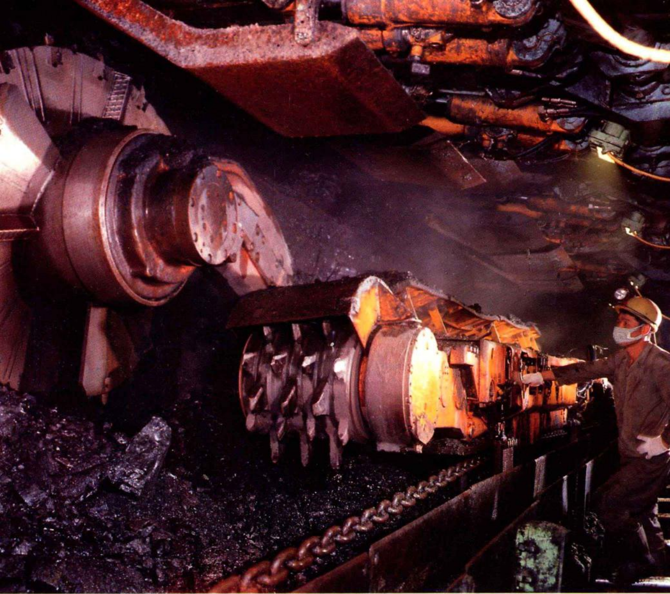
安州地区煤矿联合企业采煤场
