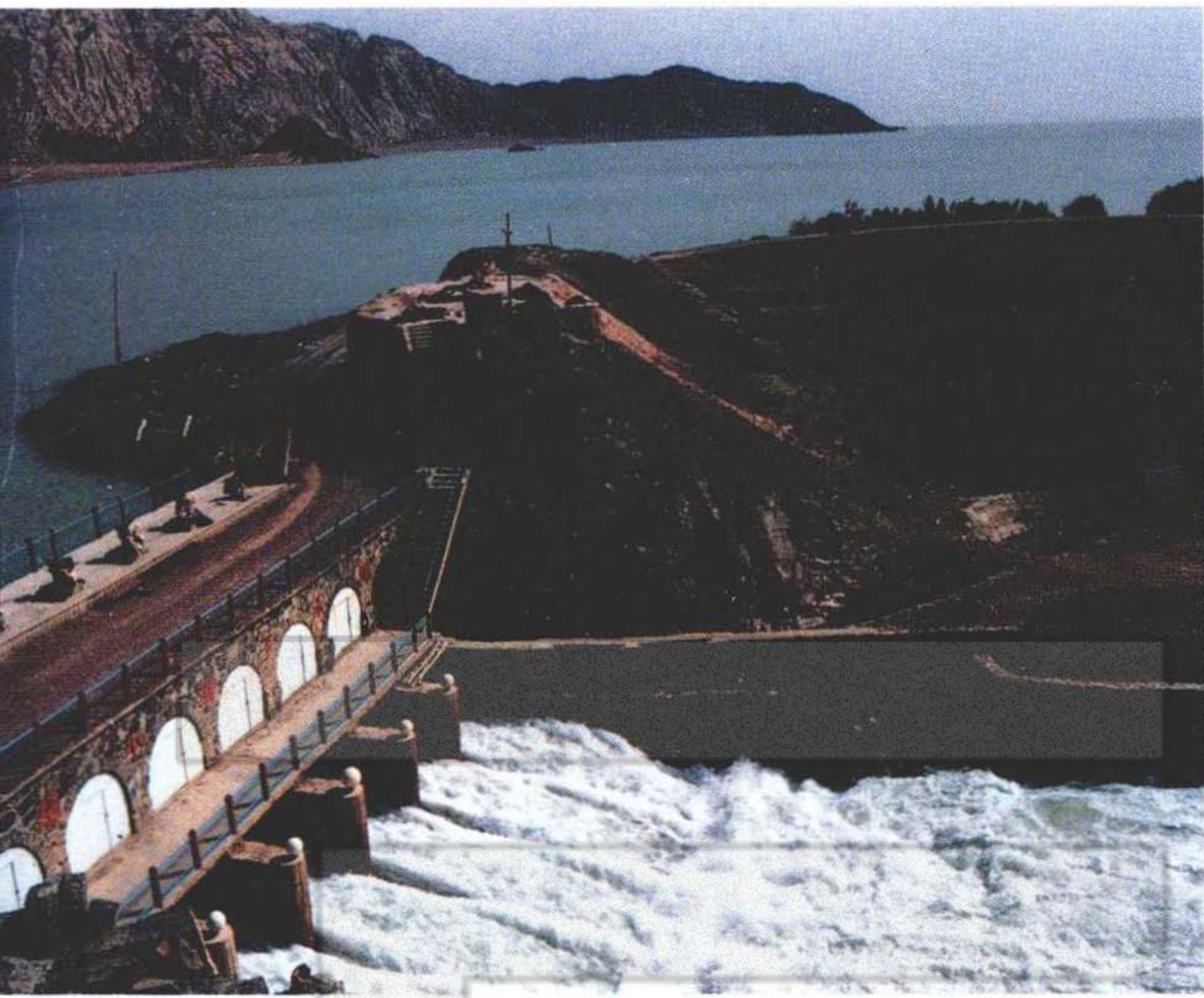
小海子水库放水闸
