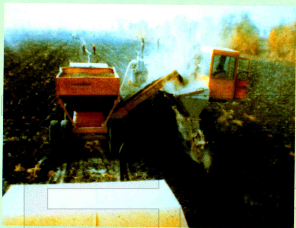
◀ 20 世纪 80 年代末农二师 29 团用挖沟埋管机实施暗管排水工程。
