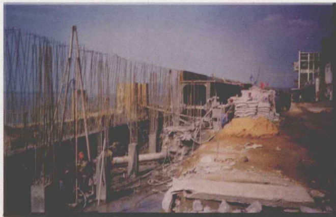
▲ 水泥帷幕灌浆现场
