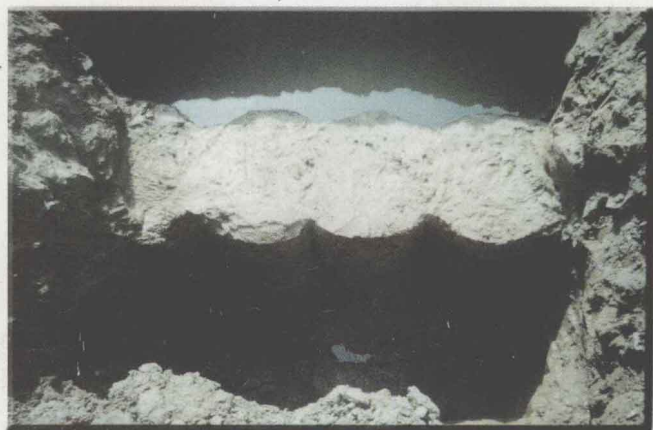
▲ 开挖检查桩体现场
