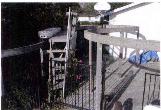
右中图：1997年8月，彼得森正在制作轨道的照片。为了制作轨道的弯曲部分，在试验了各种方法和材料之后，彼得森最终选择了胶合板。为了让木头更容易变形，他先把木材在自家的游泳池里浸泡了一段时间。他说，这一过程中最大的困难在于将各部分粘在一起时木头弯曲的形状很难保持。
