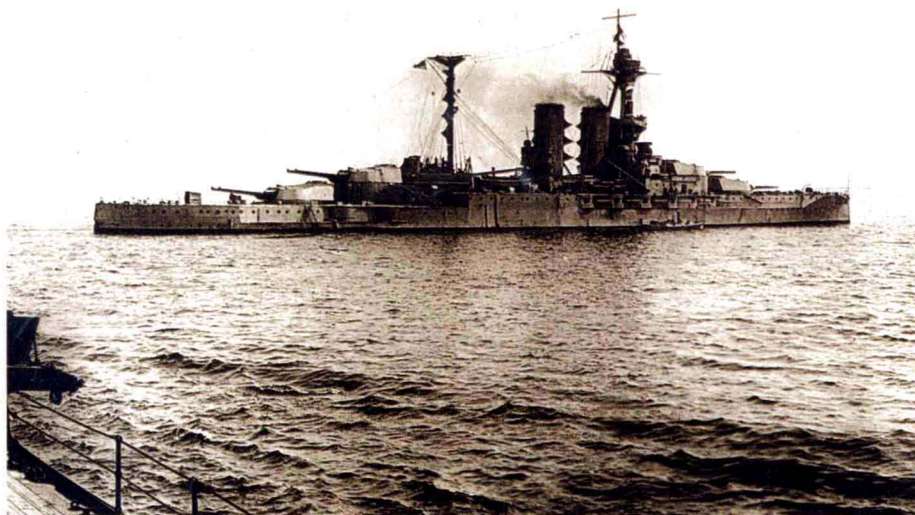
在英国战列舰“沃尔斯派”号上，可以看到早期的对抗措施。锯齿形的帆布条挂在烟面上，用以伪装外形，并迷惑敌人，使其测距仪难以准确测定其目标的位置和路线。
