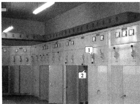
图 1-28 变电站的母联（盘前看）
