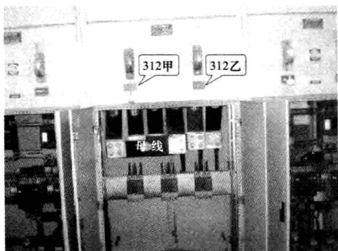
图 1-25 变电站低压母联隔离开关 操作把手和编号
