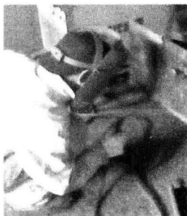
图 1-13 正在进行焊接操作
