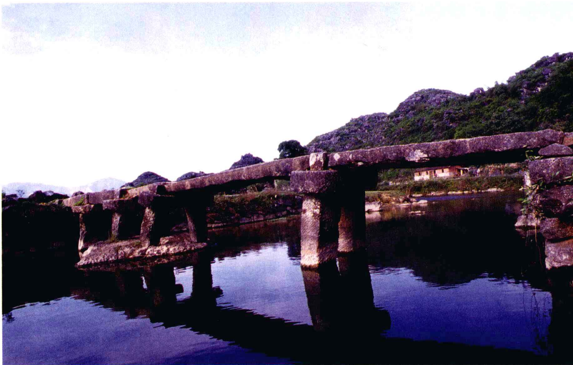
■ 湖南江永上甘棠塘村宋代古桥寿隆桥。寿隆桥是石卯榫桥，这是我国目前发现的最早的卯榫桥
