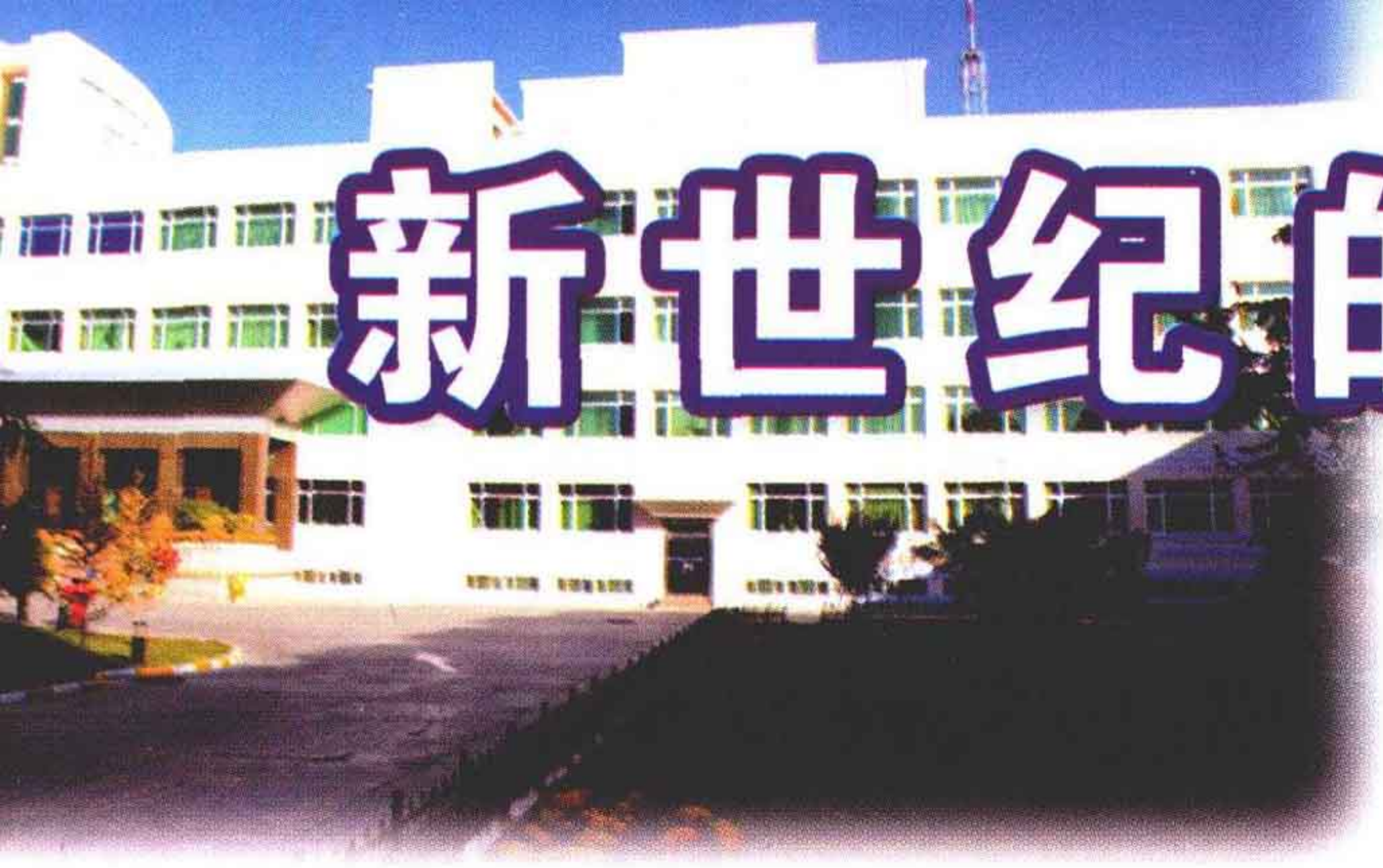
雄伟的伊犁电信大楼
