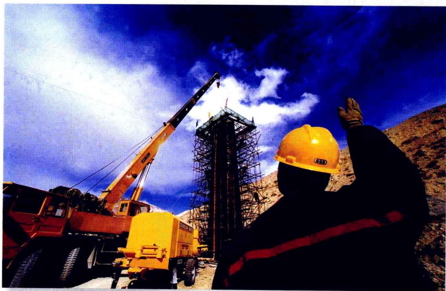
青藏铁路无名沟桥地吊装桥墩钢模
