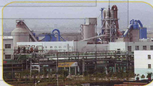
电石渣制水泥循环经济项目
