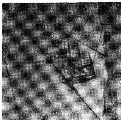
拉索防护施工中
