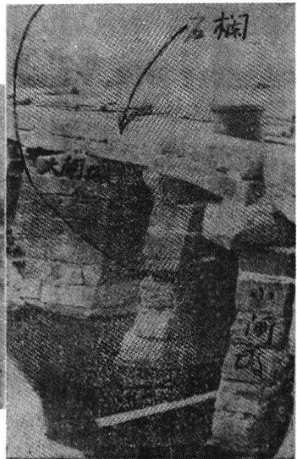
閘之西端翼牆 漏水狀況
