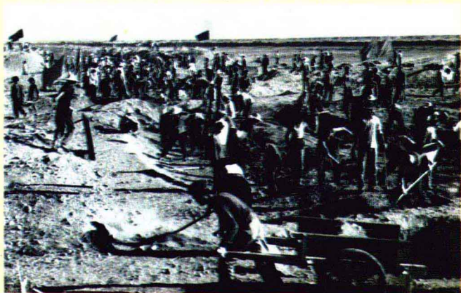
◀ 工程支队修 建上游水库的场 景。(1960年)
