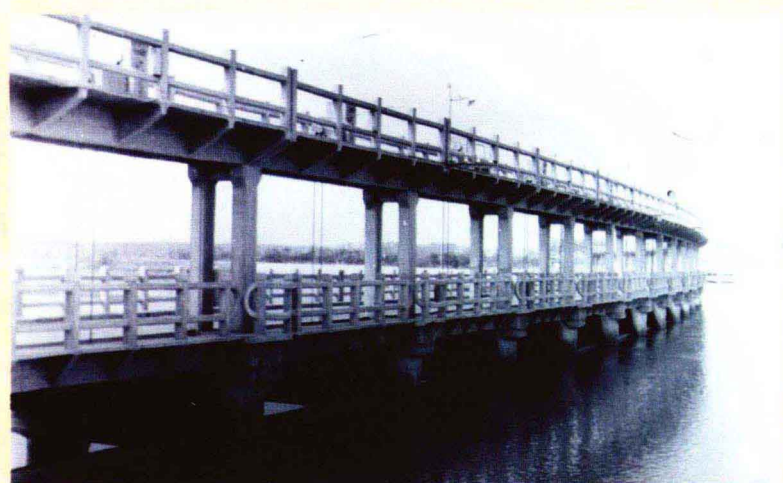
▲ 十六团动工修建的塔里木拦河闸竣工蓄水。(1972 年)
