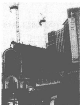
图5 上部结构施工，下部装修跟上
