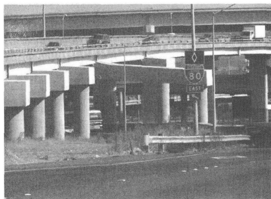
图2-1 钢筋混凝土单弯矩构件
