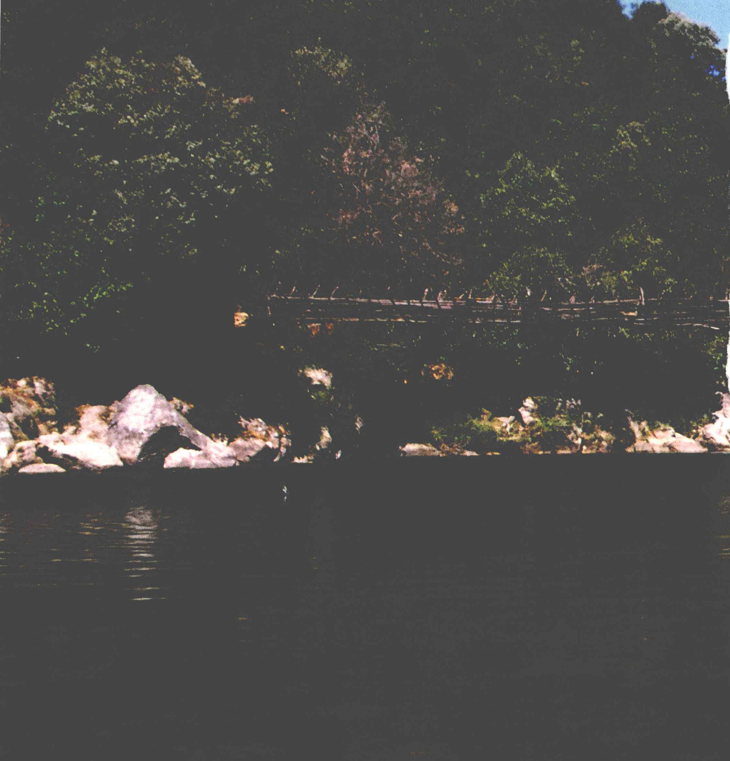
三叔河藤桥 藤桥是最古老的桥梁，利用原始森林中的藤条或是竹子建成悬索桥，以渡溪流，并有专门的称谓叫“笮”，或称为绳桥。
