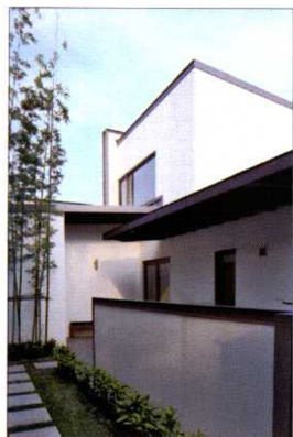
涵璧湾花园一期 The Bay, Phase 1
