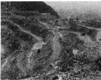
照片1-3 某露天矿开采边坡
