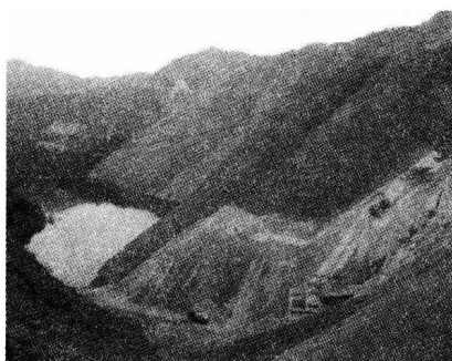
照片 1-5 排土场边坡
