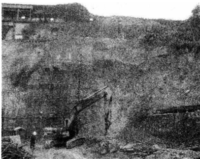
照片1-4 边坡(土坡)加固现场
