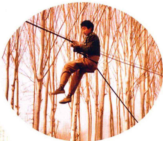
架空光缆施工
