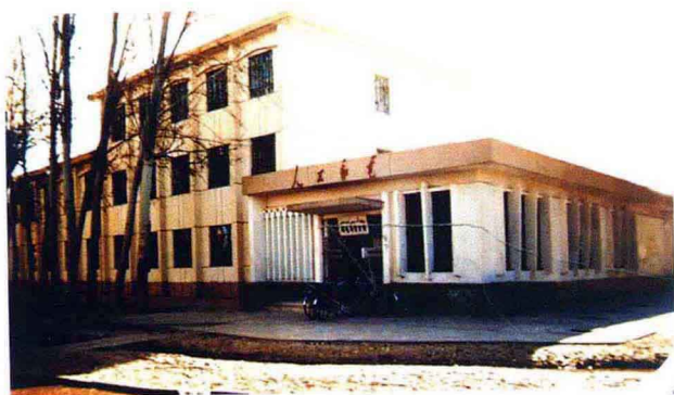
1992 年竣工的皮山县邮电通信楼
