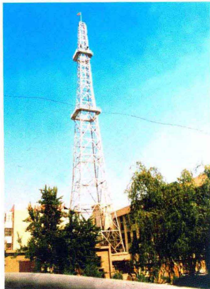
微波通信铁塔
