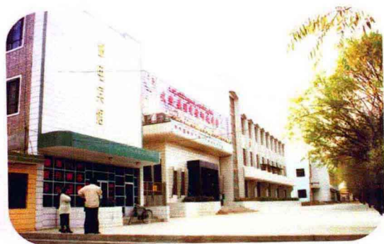
1994 年竣工的策勒县邮电通信楼
