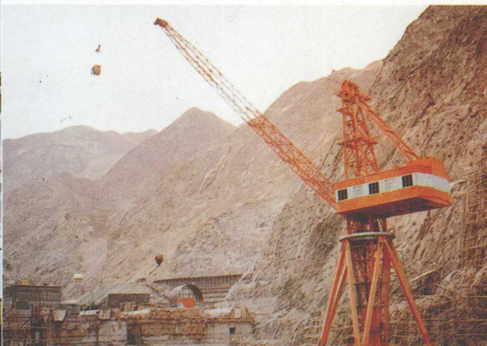
李家峡水电站正在加紧建设
