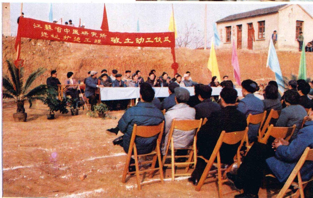
江苏省中医研究所迁址扩建工程破土动工仪式。
