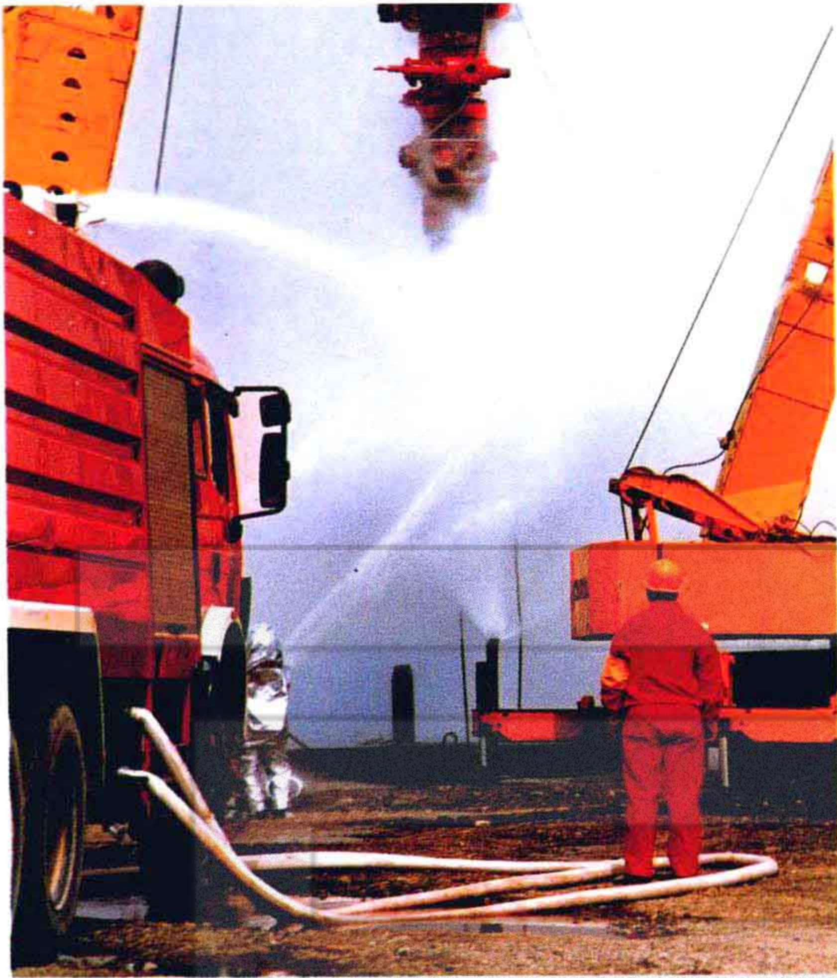
在制服迪那 2 井井喷抢险中吊装 105 兆帕新井口装置 (杜文祥摄)
